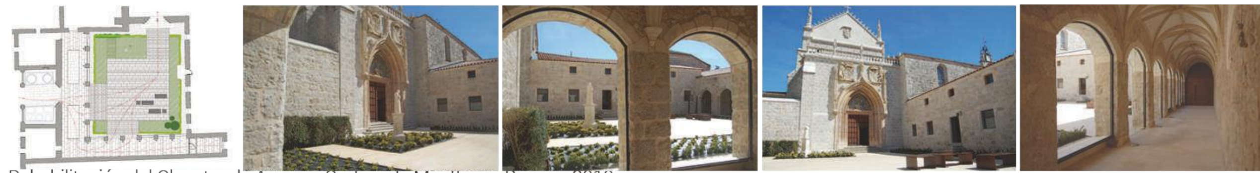
Rehabilitación del Claustro de Acceso. Cartuja de Miraflores. Burgos. 2010
