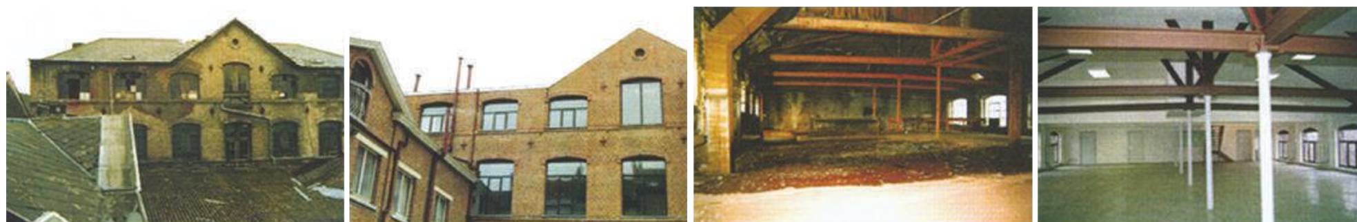
Renovación de la Nave Industrial del siglo XIX. Bruselas. 1990
