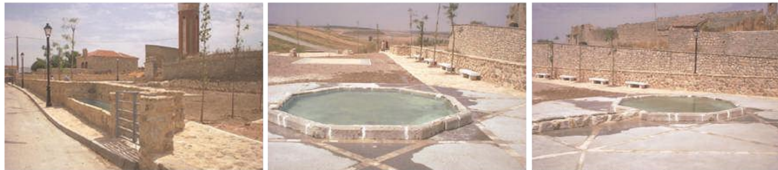
Restauración de Fuente y Abrevadero. Montealegre de Campos. Valladolid. 2003
